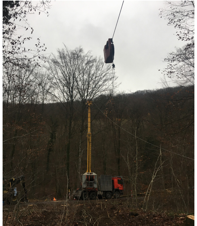
Fertig montierte Seilkrananlage mit abgespannten Trageseilen
